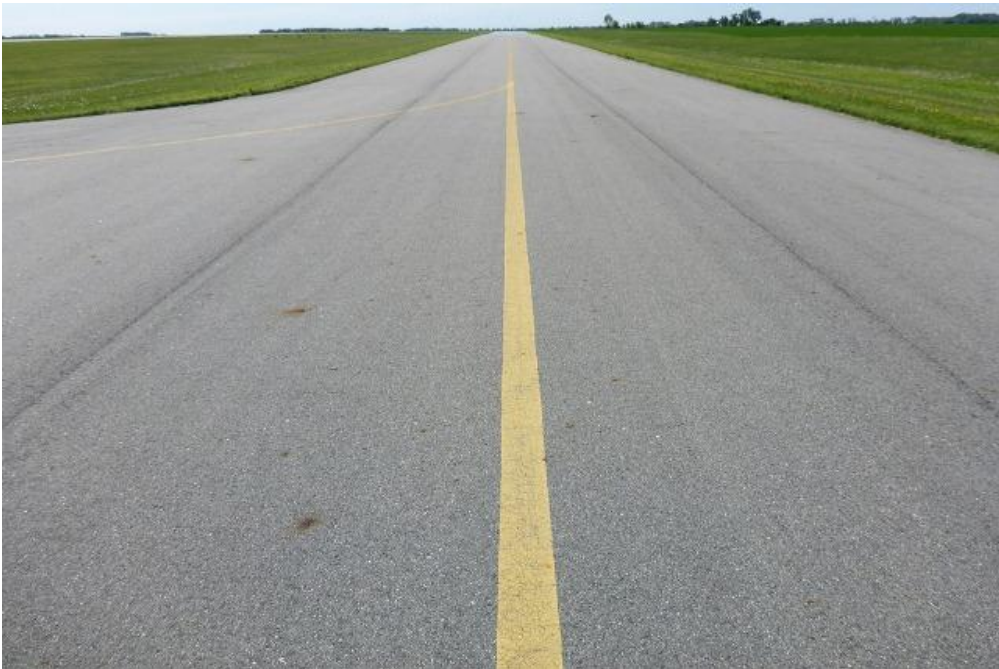
CKN PTA 002 (PCI =98)
