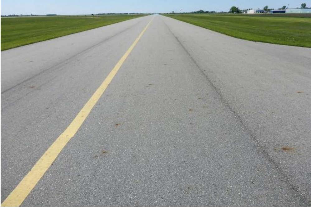
CKN PTA 001 (PCI =94)
